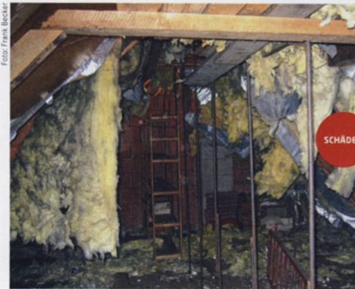
Die Waschbären hatten die Glaswolle-Dämmbahnen herausgerissen und in der Ecke einen Kot- und Urinierplatz eingerichtet.
