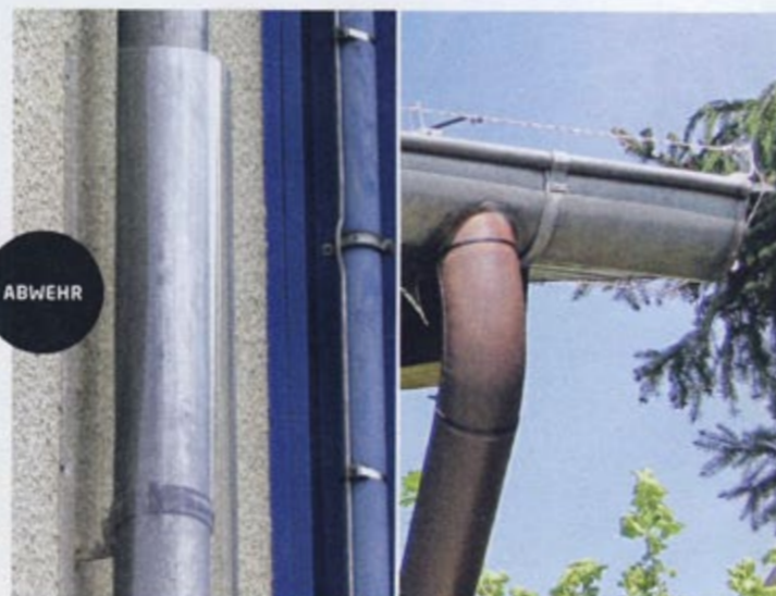
Dezente Plexiglas-Aufstiegshindernisse (l.) an Fallrohren oder Elektrozaune (r.) an Regenrinnen halten den Waschbär draußen.
