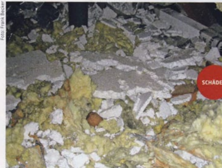
Hier wurde die komplette Dämmung aus Glaswolle und Styropor in Kleinteile zerlegt und zerstört.
